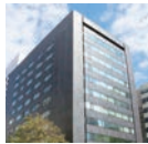
札幌分室 日本生命北門館ビル4F
